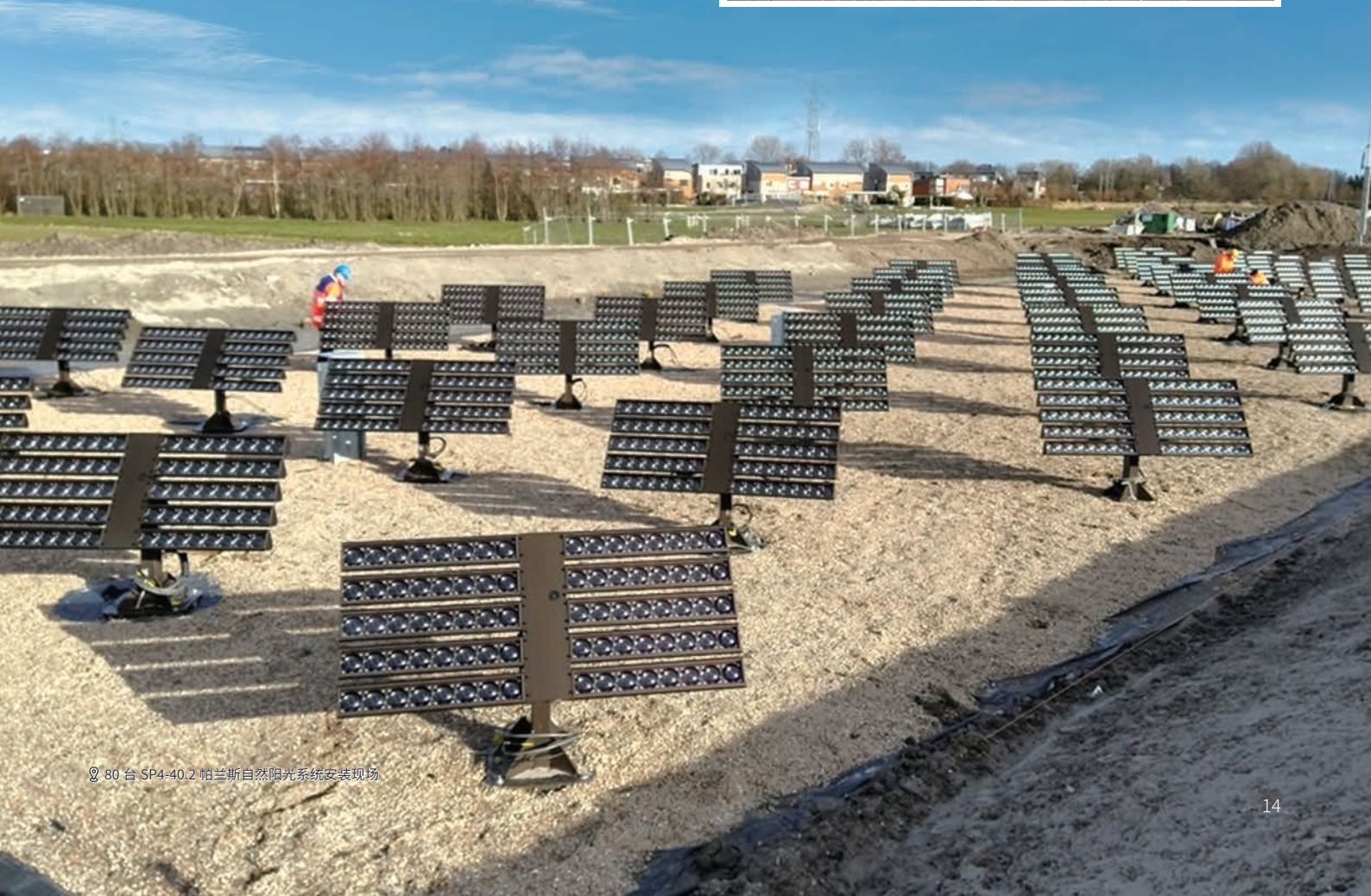
80 台 SP4-40.2 帕兰斯自然阳光系统安装现场
